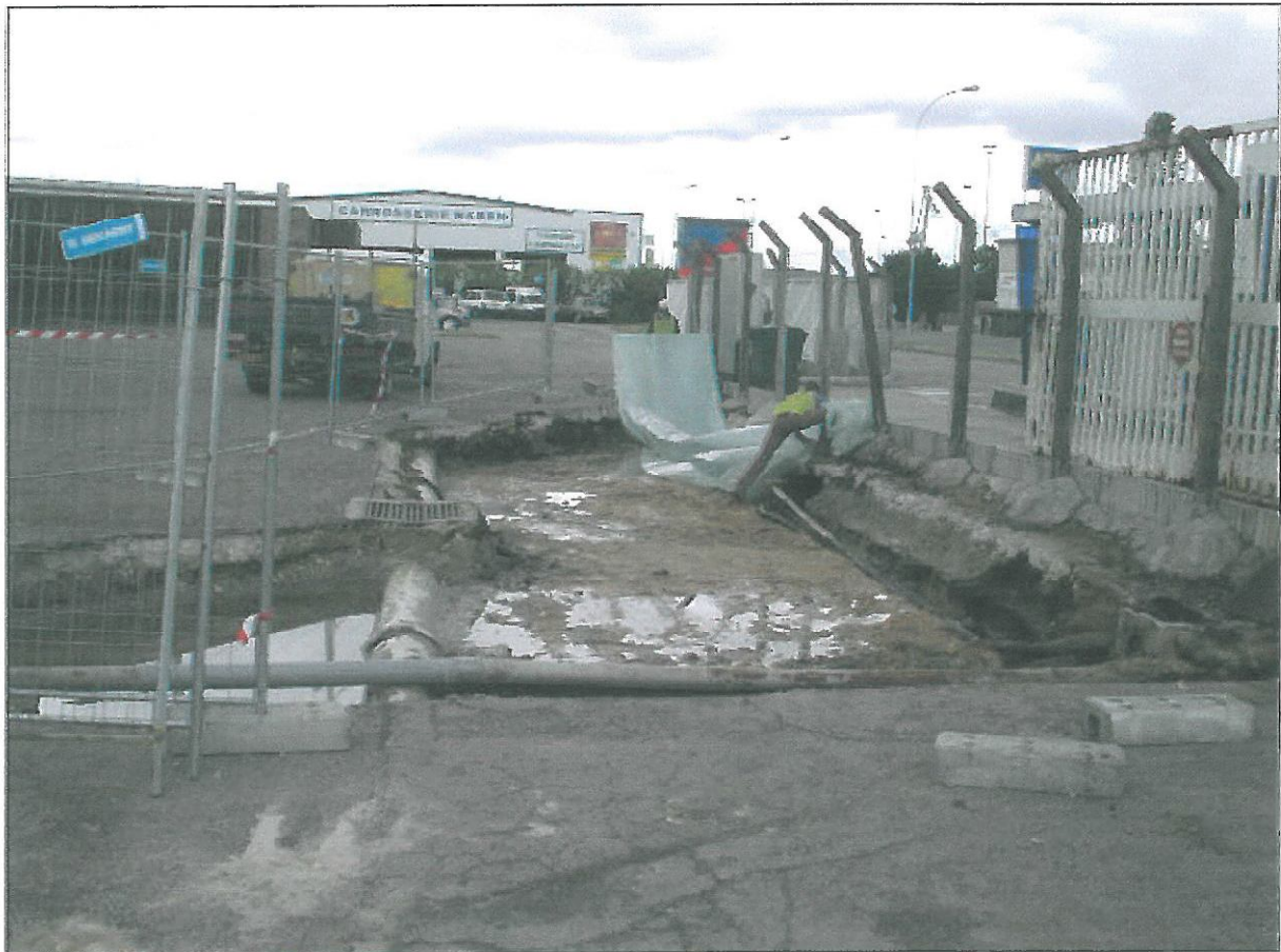
Vue de la zone d'extension Des travaux de dépollution.
